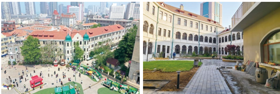
圣心修道院沿街道外立面及内院修缮后实景图
